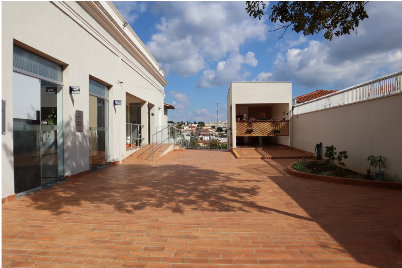
Foto do terraço da Secretaria através do portão na Rua 13 de Maio. Autoria própria, abril de 2023
